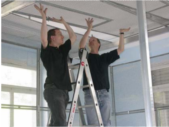
Thomas Demarmels und Ivo Bundi montieren die Deckenelemente.
