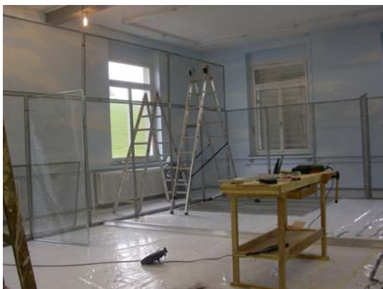
Die ersten Wandelemente stehen.
